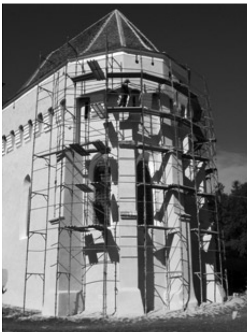
Evangelische Kirche in Großscheuern in Renovierung, Stand 6. Oktober 2010. Foto: Hans Martin Gräf
