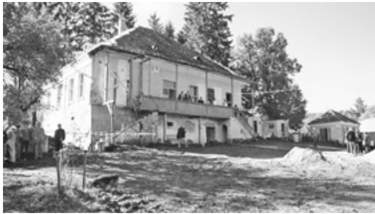
Das geräumige Pfarrhaus in Radeln soll gründlich saniert werden. Foto: Christine Chiriac
