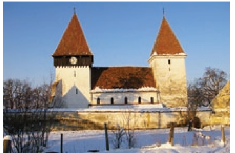
Mergeln. Romanische Basilika und Glockenturm im Westen wurden im 13. Jahrhundert errichtet, im 15. Jahrhundert zur Wehrkirche umgebaut. In dieser Zeit wurde der Ostturm, der ursprünglich auch einen Wehrgang besaß, über den Chor gesetzt. Die Ringmauer entstammt dem 16. Jahrhundert, von ihren vier Ecktürmen sind noch zwei vorhanden. Foto: Friedrich Schuster
