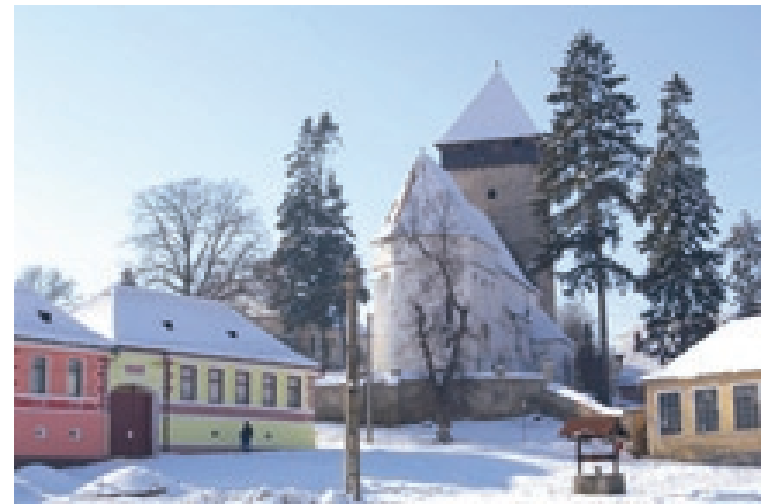
Roseln. Gotische Saalkirche aus dem 15. Jahrhundert, die 1509 zur Wehrkirche umgebaut wurde. Über dem Chor befindet sich ein Wehrgeschoss auf Strebepfeilern mit Stützbogen und Gusscharten. Der siebengeschossige Glockenturm kann nur aus der Kirche betreten werden. Ringmauer und Wehrtürme wurden im 19. Jh. abgetragen. Foto: Schuster
