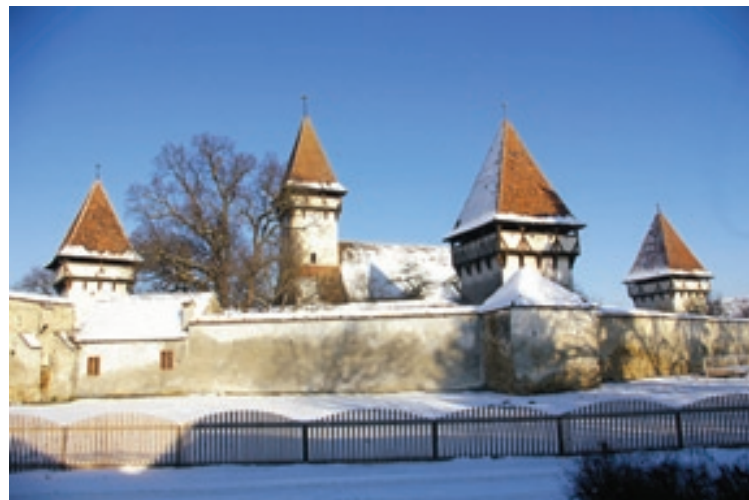
Kleinschenk. Saalkirche von 1421. Die Jahreszahl steht an der Südwand des Glockenturms, der einen auf Hängeböcken vorgekragten Wehrgang besitzt. Die hohen Ringmauern, im Südwestabschnitt verdoppelt, werden von vier dreigeschossigen Türmen mit steilen Pyramidenhelmen verstärkt. Foto: Friedrich Schuster
