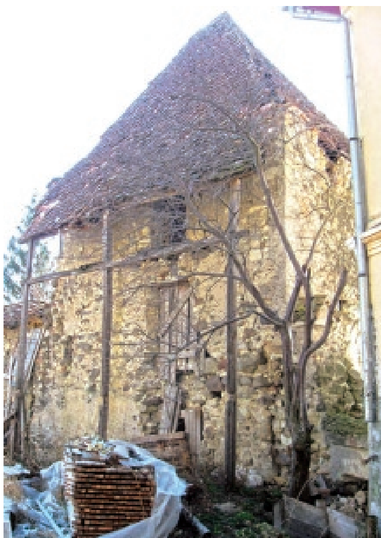
Der südliche Flankierungsturm der Draaser Kirchenburg ist – anders als der östliche Turm – noch gedeckt, aber die Bausubstanz ist durch Regen und Witterung stark angegriffen. Foto: Andreas Lapidum
