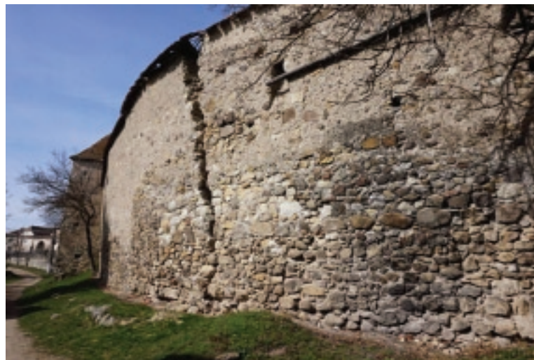
Der Riss in der Ringmauer der Draaser Kirchenburg ...Der Riss in der Ringmauer der Draaser Kirchenburg bleibt nach Abbruch der Renovierungsarbeiten bestehen. Die Mauer neigt sich gefährlich und muss abgestützt werden, der Zusammenbruch ist absehbar. Foto: Andreas Lapidum
