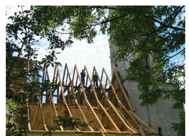
Die Dachkonstruktion der Alzener Kirchenburg wurde teilweise erneuert und das gesamte Dach neu gedeckt. Foto: Hans Tekeser
